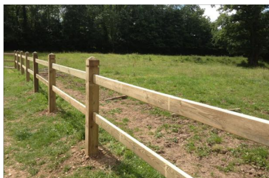
Figure 4 : Exemple de clôture perméable à la faune
