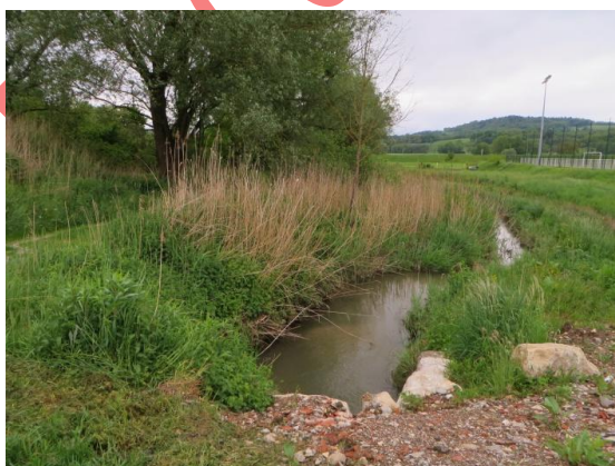
Photo 5 : Passage sous la rue Francis Goddet
