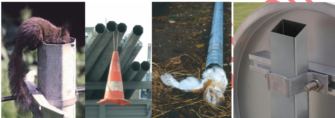
Figure 8 : Les poteaux creux constituent des pièges mortels pour la faune et doivent être obstrués de façon durable par des dispositifs métalliques (le plastique se dégrade et est non durable)
