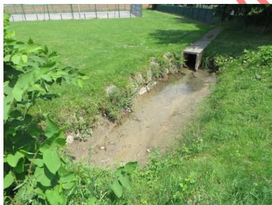
Photo 4 : Aqueduc sur la partie amont
