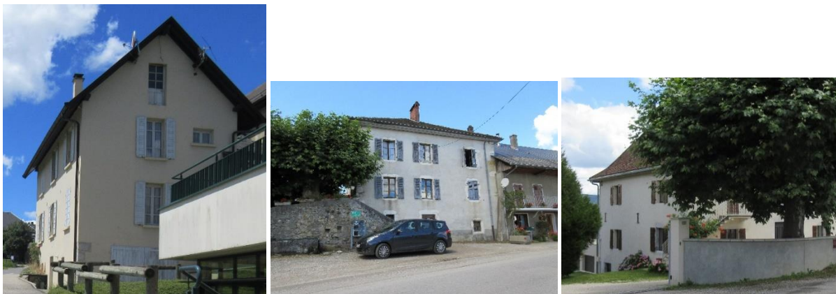
Photo 2 : Constructions de type R+2+c à La Combe
