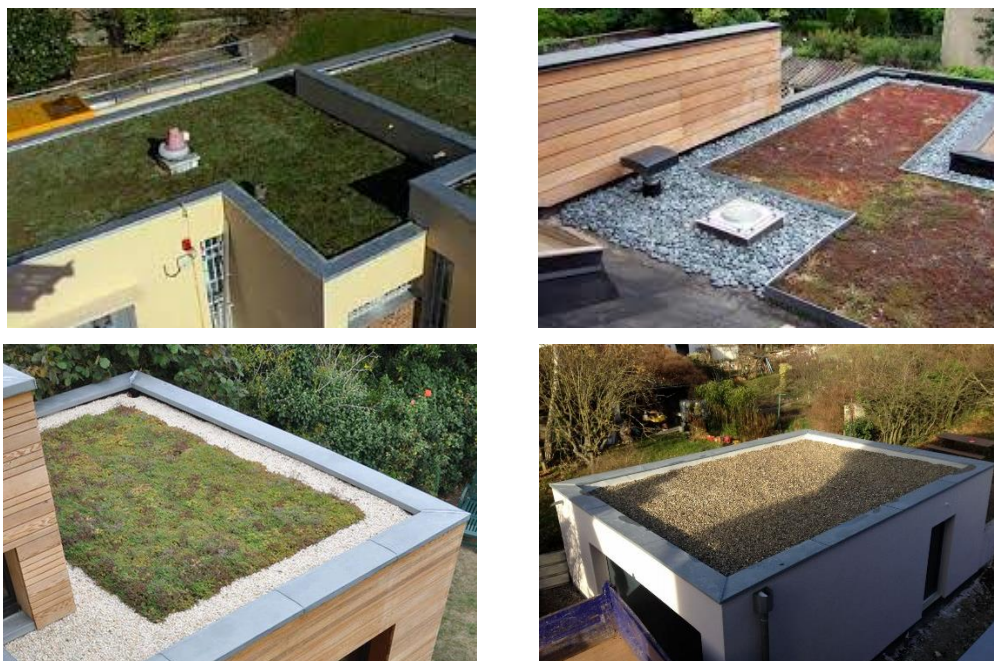
Exemples de toitures stockantes (végétalisées ou non)
