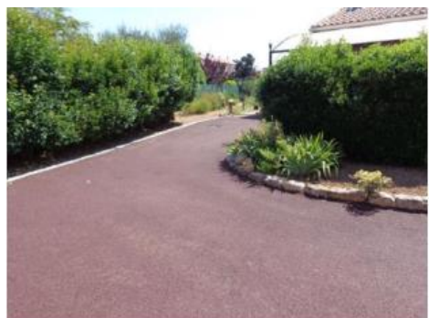
Allée/parking en enrobé poreux (source : Celtivia)
