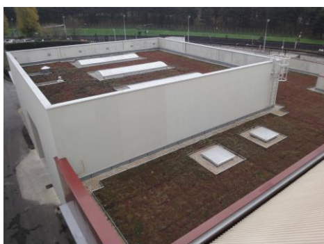
Toiture terrasse stockante
