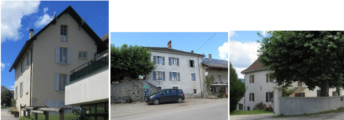
Photo 2 : Constructions de type R+2+c à La Combe
